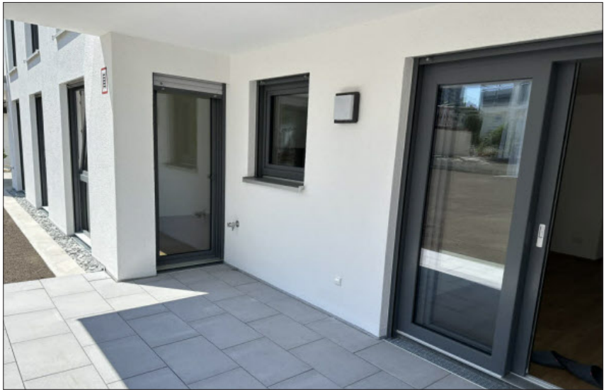
Schiebetüren an den Terrassen öffnen den Raum nach draußen.
