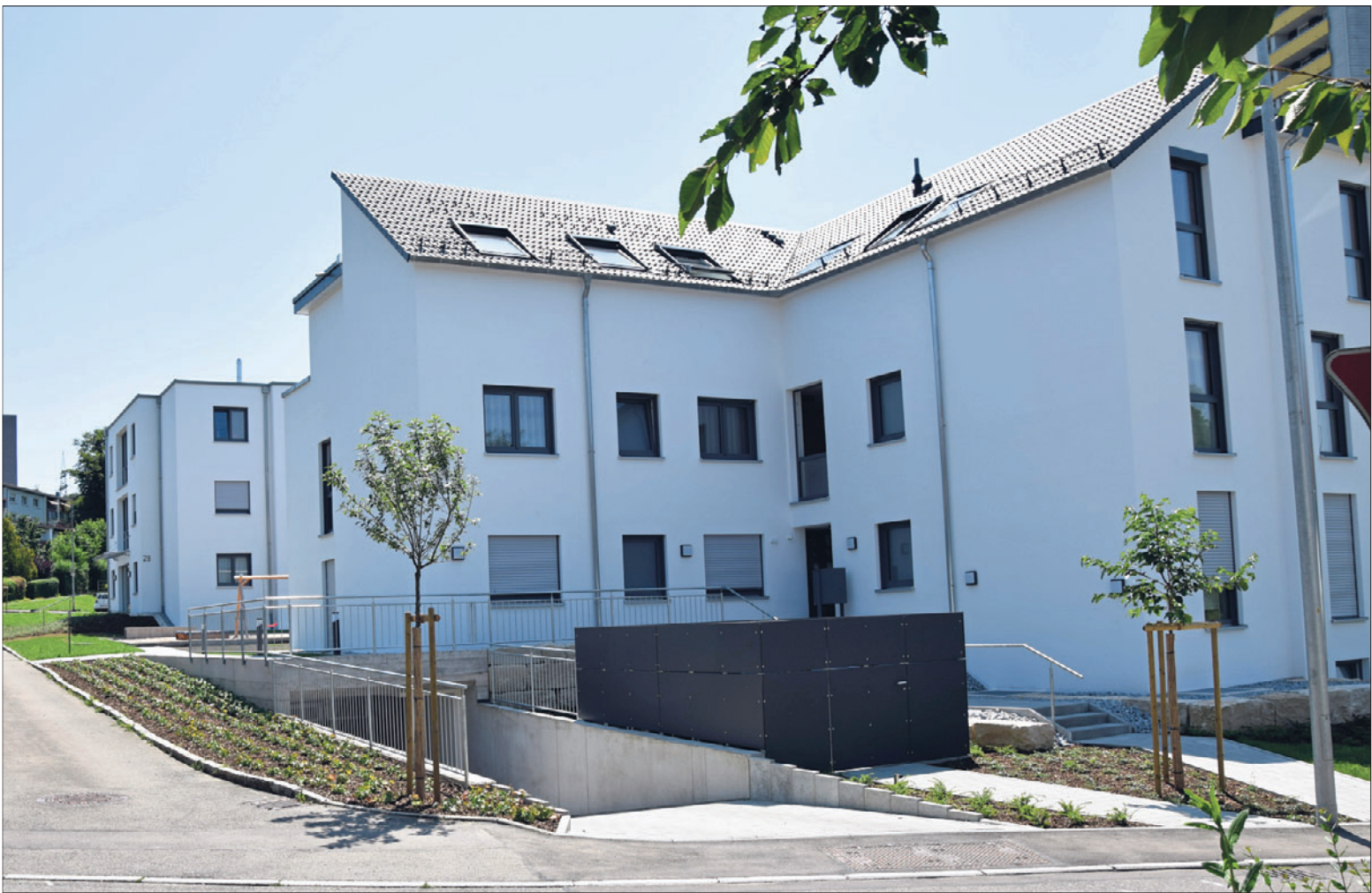
Vom Grundweg her geht es in die Tiefgarage.
